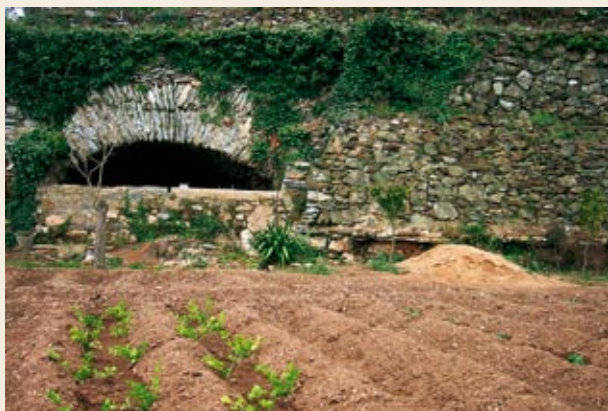
La mina recoge el agua que abastece la Font del Portal y el depósito del pueblo
